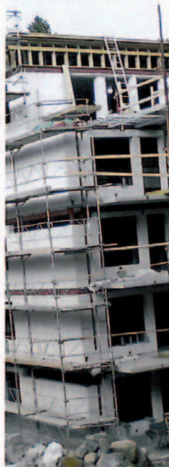
Veidekkes nya fuktsäkra väggkonstruktion testas i Gubbängen.
